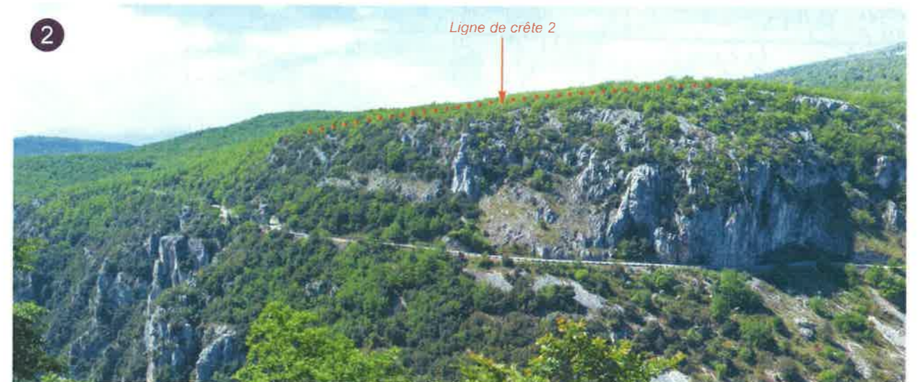
Vue prise depuis le parking visiteurs. La ligne de crête 2 interdit toute vision sur la variante d'extension n°1 ainsi que sur les fronts supérieurs de la carrière de Bar-sur-Loup.
